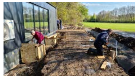
Udgravning til rottesikringen rundt om kommende træterrasse og skur.
